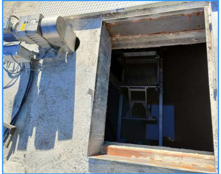
Instalamos UNA reja de medios RevTech® Nw41 en canal metálico, en una arqueta aislada, instalamos un sistema de transmisión piñón-cadena, porque el motorreductor no podía quedar en el interior debido a la afectación de este por la acumulación de gases como el ácido sulfhídrico, para tratar un  $Q=65\text{m}^3/\text{h}$ , luz de paso 15mm, en AISI-316L.
