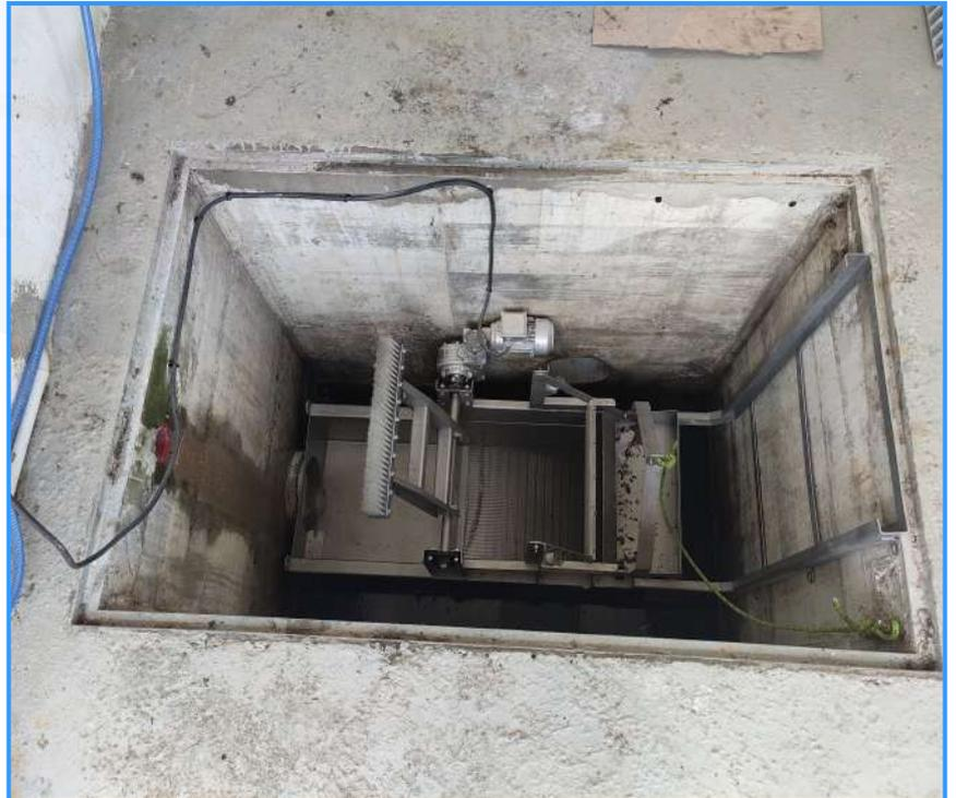
Un Reja de finos RevTech® Nw42, para tratar un  $Q=10\text{m}^3/\text{h}$ , Malla de filtración conformada por perfil triangular tipo Johnson de luz de paso de 2mm, material de construcción principal en AISI-304L. Diseñamos un canal metálico para conducir el agua a tratar, personalizado a la obra civil existente. Sistema de guías y cesta de recogida de residuos móvil para su fácil extracción.
